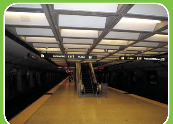
Poca iluminación en la plataforma
